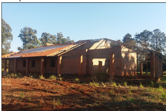
Fachada y galería
